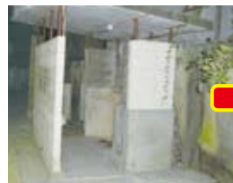
改修前(西側より)
