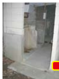
改修前(東側より)
